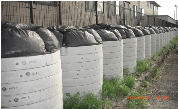
教会近くのアパート軒下に並べられた汚染土 (黒いカバーの劣化が懸念されている)
