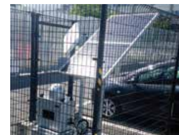
モニタリングポスト(郡山市役所)
