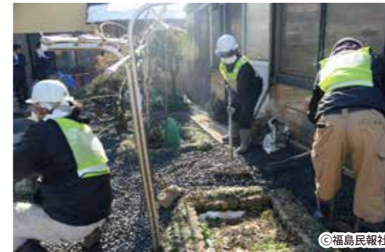
住宅除染で庭に砂利を敷き詰める作業員＝郡山市
