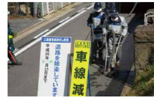
住宅地の道路を除染している様子(2014年10月)
