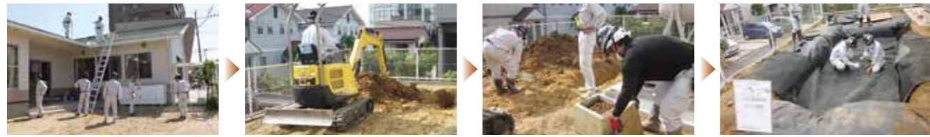
放射線量の高い表面の土を剥ぎ取り、その下に埋めています。
