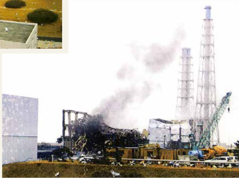
3月15日に撮影された第一原発。左から1~4号機。14日に爆発した3号機は枠組みも崩れ、白い煙を上げている。4号機も大きく損傷しているのが見える(東京電力提供)
